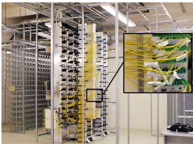
Figure 7 - Photo d'un répartiteur optique
