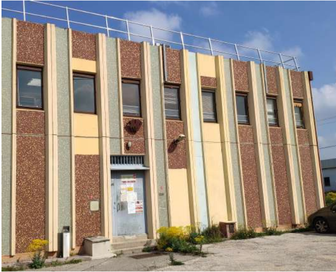
Figure 5 - Photo d'un répartiteur, vue extérieure
